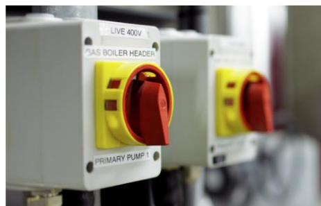
Desconexão do motor
