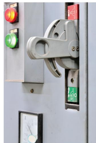
Interruptor de desconexão principal
