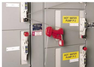
Dispositivos de isolamento de energia bloqueados pela pessoa designada.
