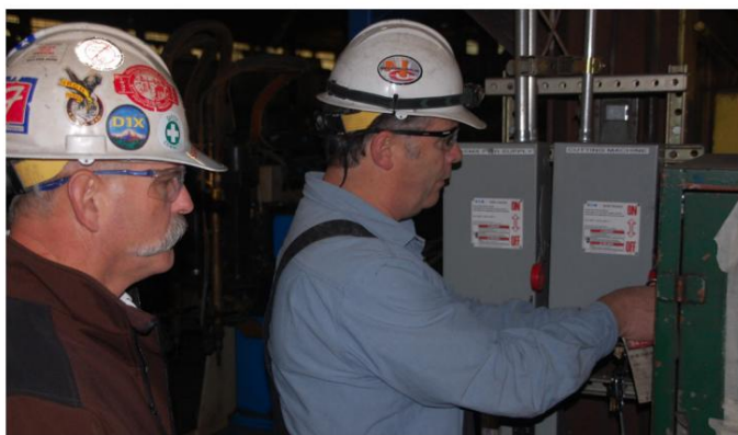
Um inspetor revisando o procedimento de bloqueio.
