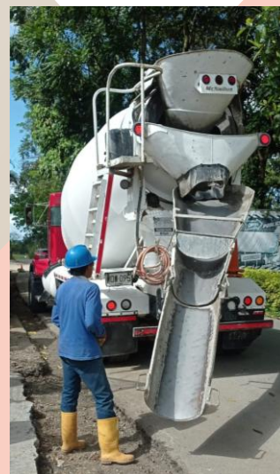
Fundición de concreto en vía – Guamal 2021
