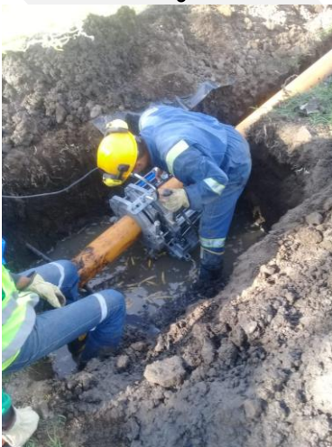
Pega en PEAD 5" Gas- Guamal 2022
