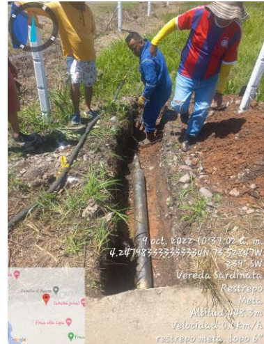
Perforado neumático para acueducto - Restrepo 2022
