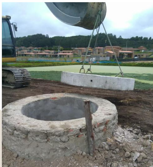
Pozo de inspección Cajicá - 2021
