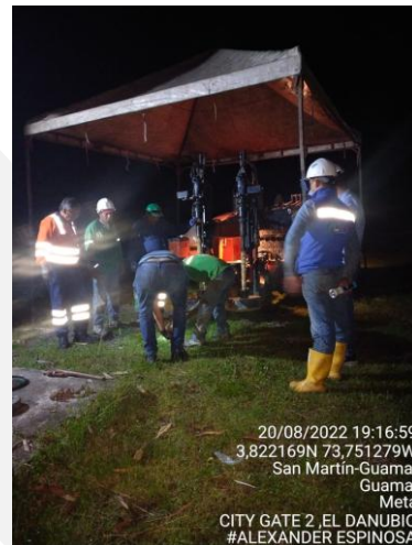
Cruce de vía para conexión de City Gate – Guamal 2022
