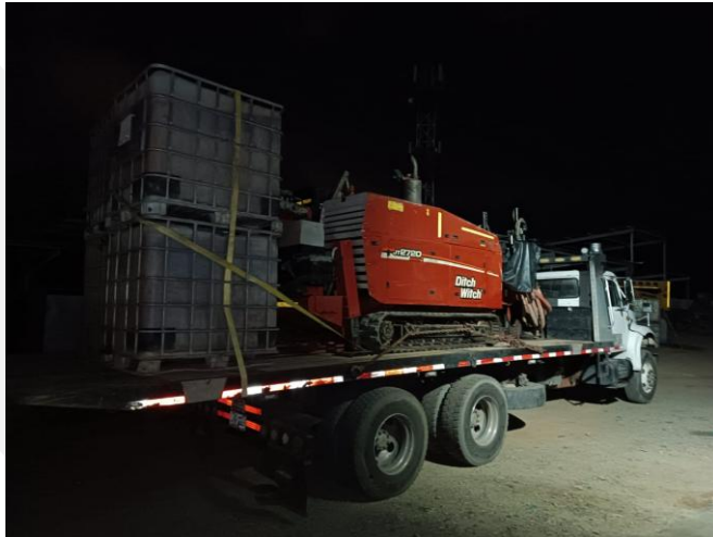
Cruce de vía nacional para línea de gas – Guamal 2022
