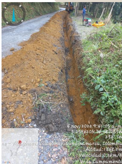
Redes de gas domiciliario Villagómez - 2022
