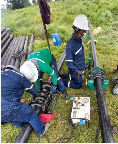
Pega en PEAD 6" Línea Eléctrica – Bogotá 2021
