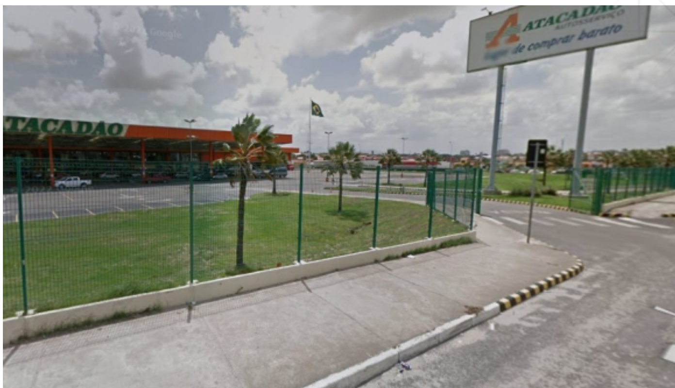
Construção de muro e gradil – Fortaleza – CE Novembro de 2018 (19.000m 2 )
