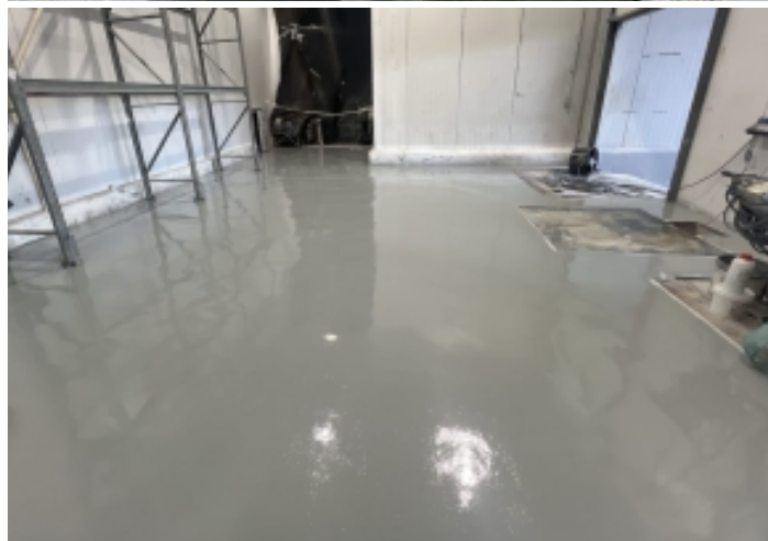
Aplicação de piso monolítico de alta resistência em câmara fria Feira de Santana – BA – novembro de 2023
