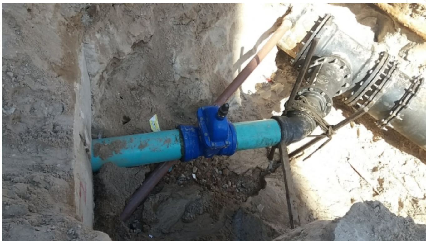
Construção de piscinão p/ retenção de águas pluviais e extensão de adutora de água – Maceió – AL Abril de 2019 (17.430m 2 )
