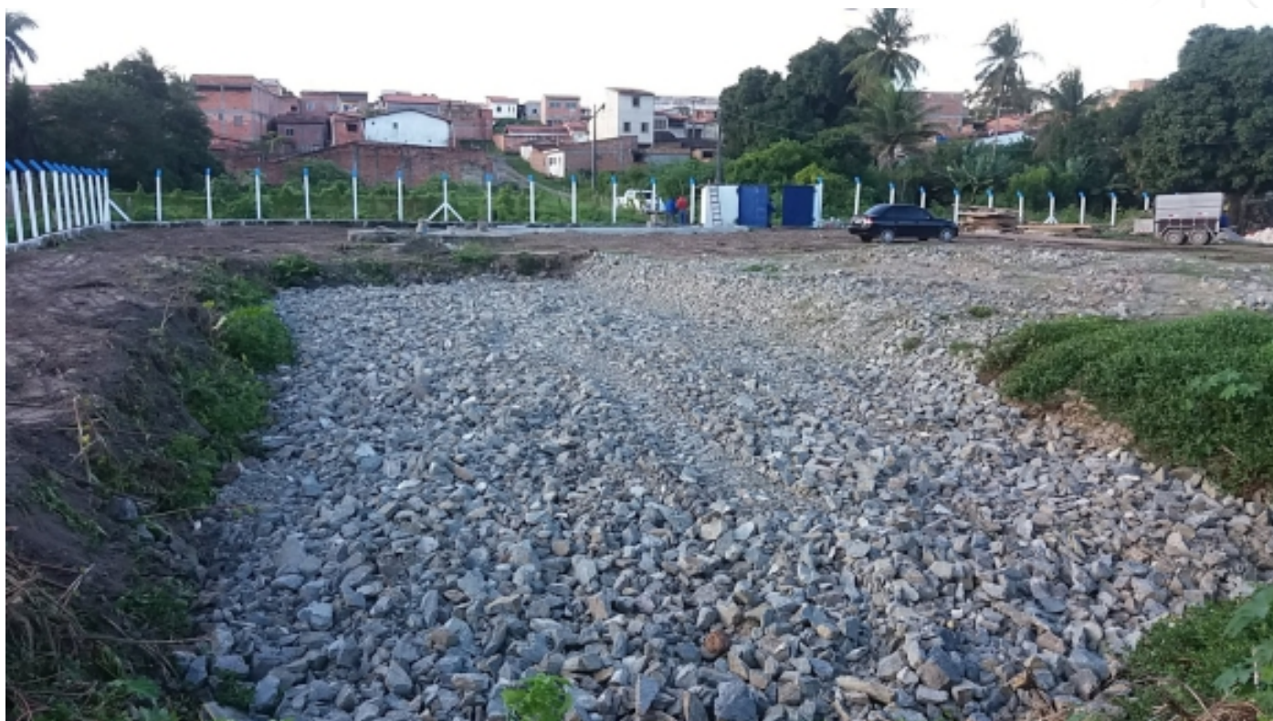
Rede de tratamento de esgoto – Alagoinhas – BA Agosto de 2019 (1.500m 2 )
