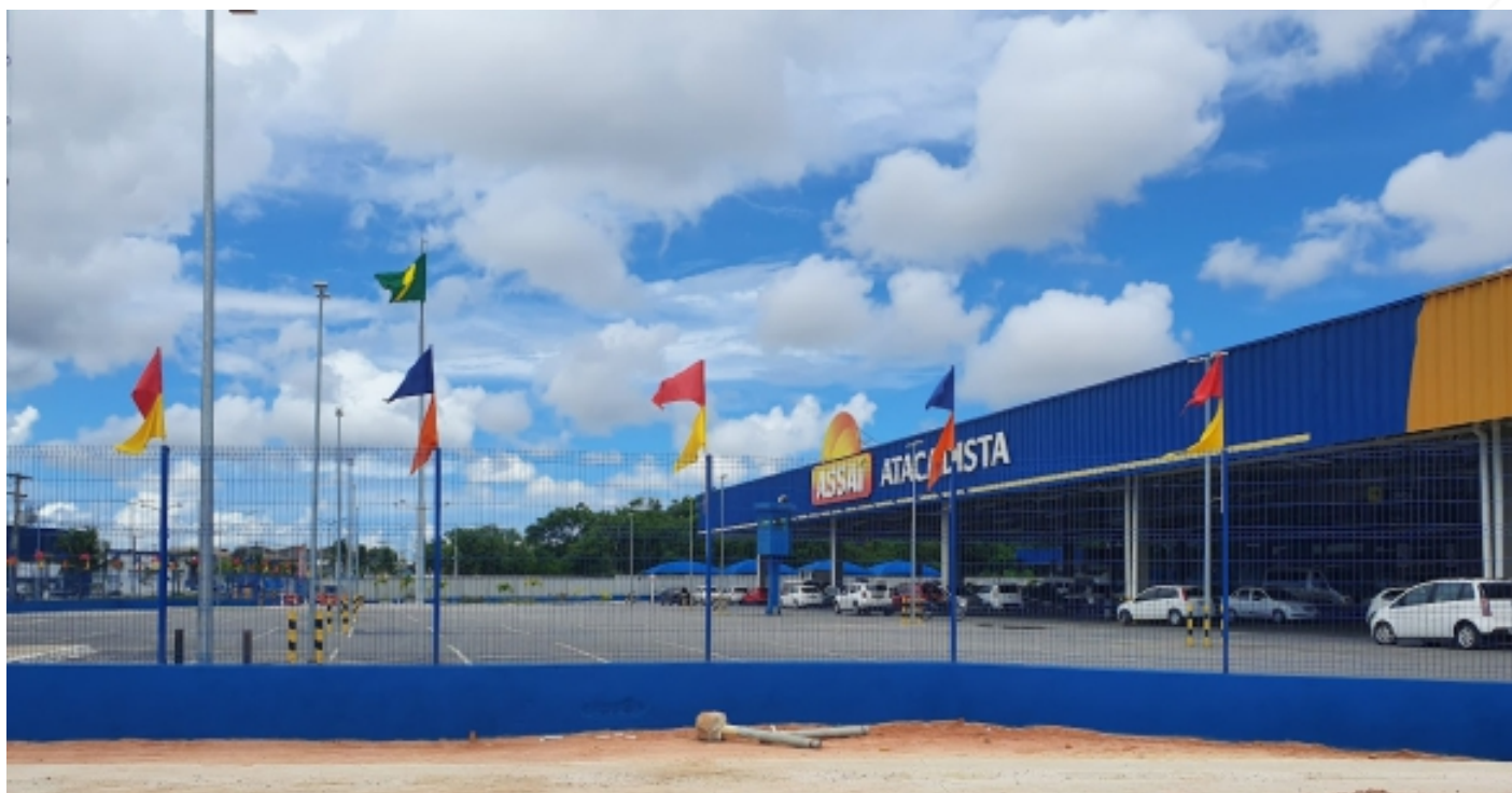
Reforma estacionamento – Camaçari – BA Março de 2020 (5,000m 2 )
