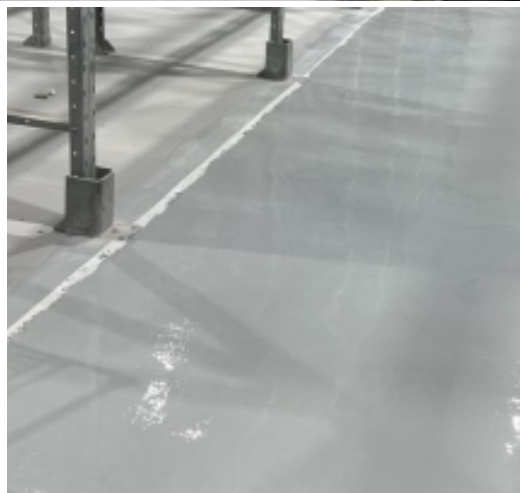
Aplicação de piso monolítico de alta resistência em câmara fria Feira de Santana – BA – novembro de 2023
