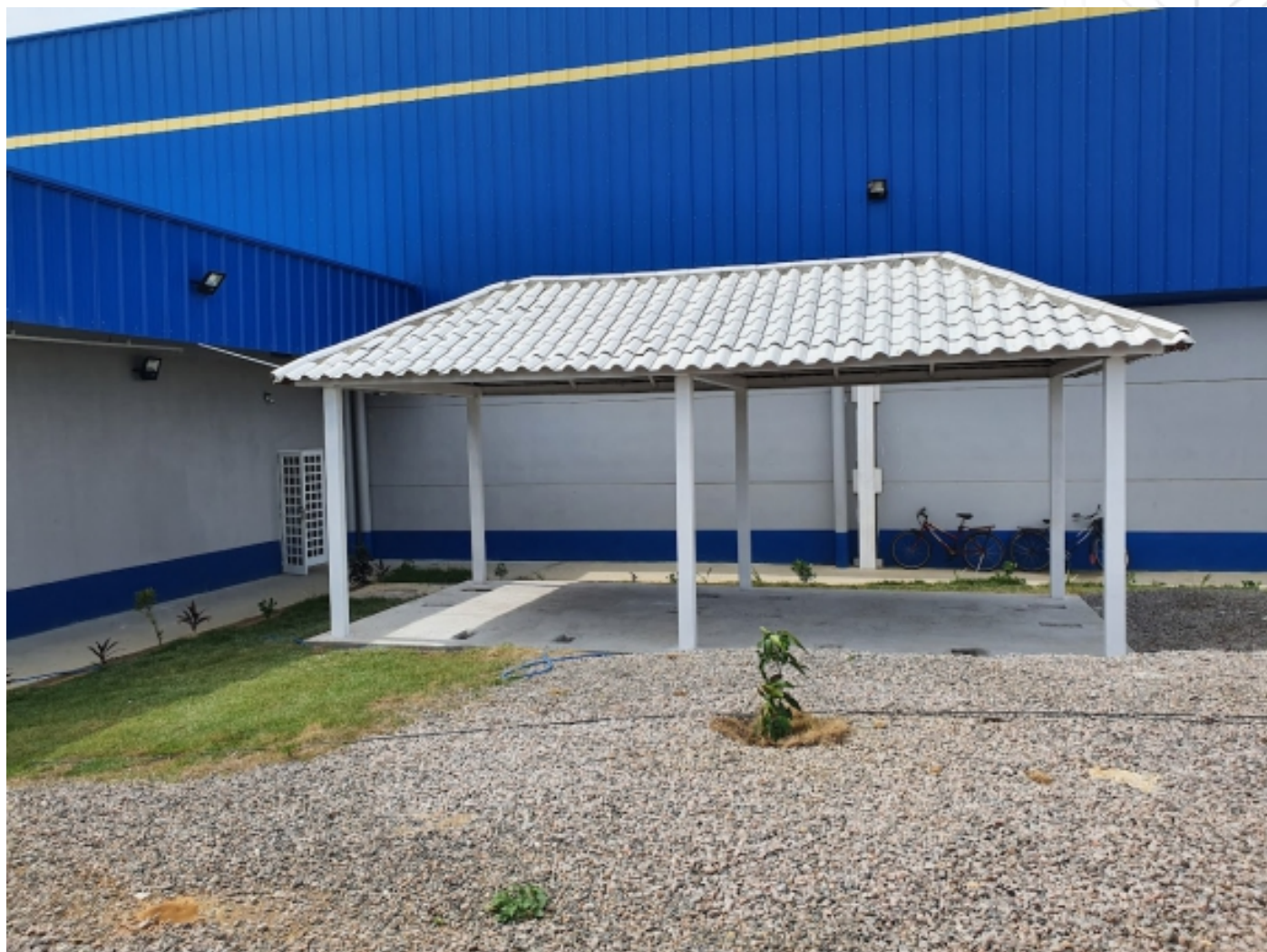
Implantação de área de descanso funcionários – Arapiraca – AL Janeiro de 2020 (85m 2 )
