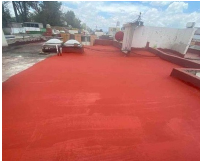
AREA IMPERMEABILIZADA TERMINADA
