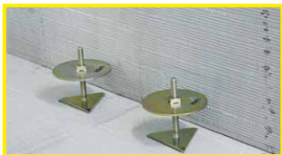
1º Posicionar niveladores.
