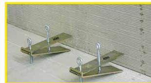
1º Posicionar niveladores.
