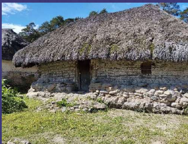
Fotografía 3. Sistema constructivo en piedra, bahareque y paja (ucha)
