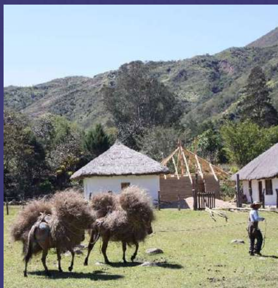
Fotografía 4. Sistema de entechado en madera y paja (ucha)
