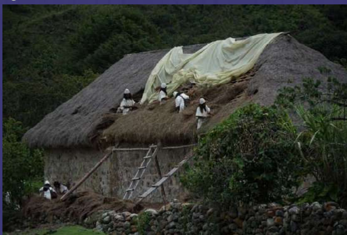
Fotografía 5. Mantenimiento de cubierta haciendo cambio de la ucha.
