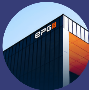
EPG, DATA CENTER MODULE SDN BHD, JB
