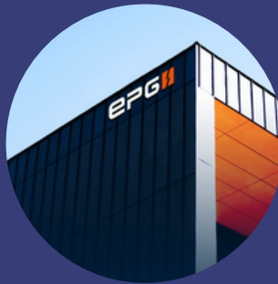
EPG, DATA CENTER MODULE SDN BHD, JB
