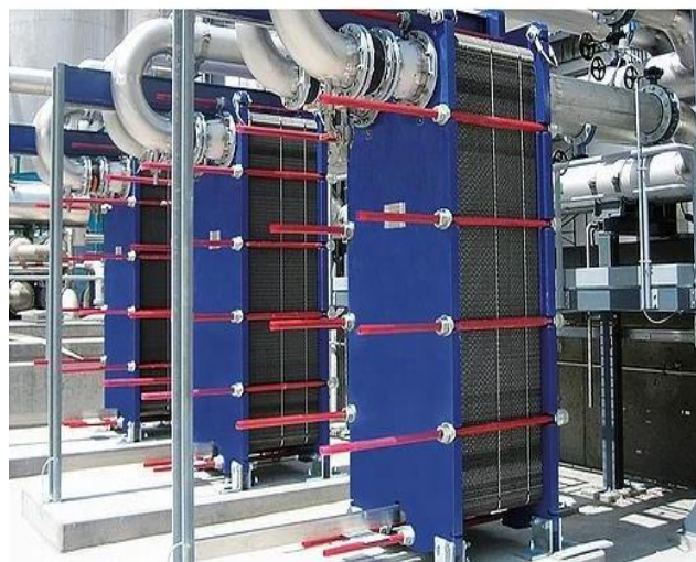
Fig. 2 Plăci montate și plăci asamblate ale unor schimbătoare de căldură industriale
