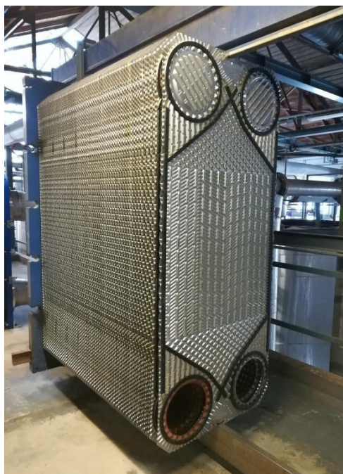
Fig. 2 Plăci montate și plăci asamblate ale unor schimbătoare de căldură industriale
