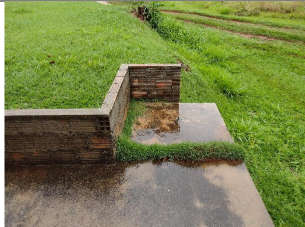
Figura 31 - Vegetação em torno da tampa da bacia de contenção dificultando a inspeção no interior da bacia – Depósito de inflamáveis
