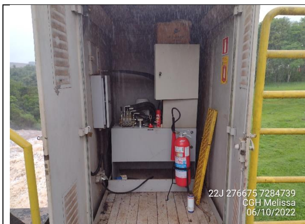
Figura 46 - Central hidráulica dos equipamentos da barragem instalada no interior do cubículo
