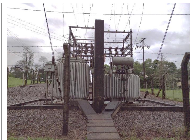
Figura 36 - Transformadores de Força instalados sobre bacia de contenção, separados com parede corta fogo - Subestação
