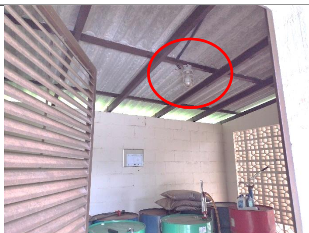
Figura 28 – Sistema de iluminação anti explosão
