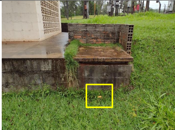
Figura 30 - Bacia de contenção do Depósito de Inflamáveis com registro de fechado.
