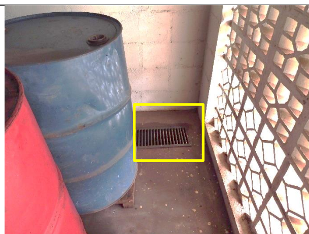
Figura 29 – Dreno que direciona para a bacia de contenção disposta na área externa
