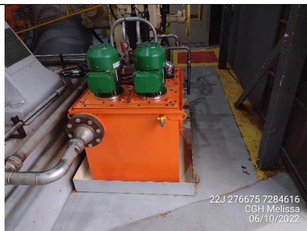
Figura 39 - Central óleo dinâmica do mancal da U2 disposta sobre bacia de contenção
