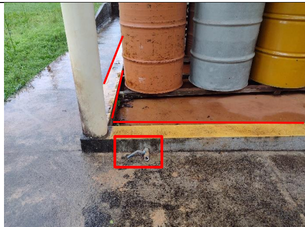
Figura 18 - Em destaque, mureta de contenção e registro fechado - Central de Armazenamento de Resíduos
