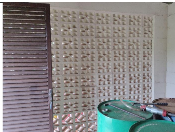
Figura 27 – Parede construída com tijolos vazados proporcionando ventilação natural no interior do depósito
