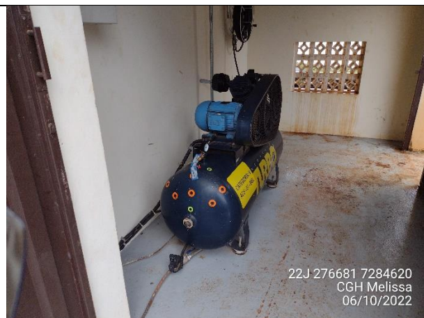
Figura 35 – Compressor disposto sobre piso impermeável, porém sem bacia de contenção.
