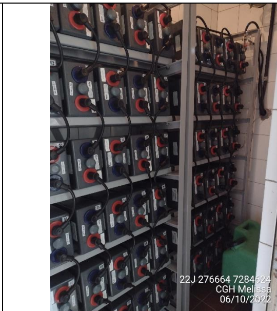
Figura 43 - Banco de elementos da sala de baterias
