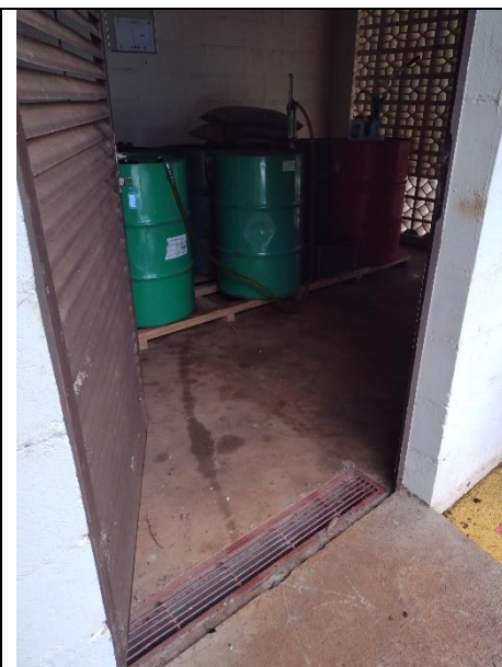
Figura 25 - Canaleta na porta de entrada do Depósito de inflamáveis
