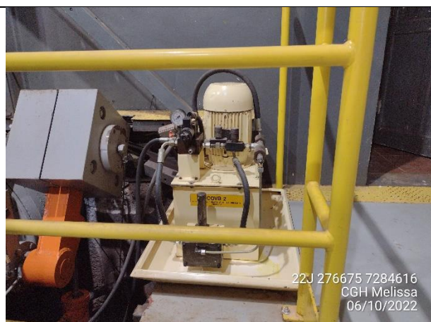
Figura 40 - Central óleo dinâmica da Válvula borboleta da U2.
