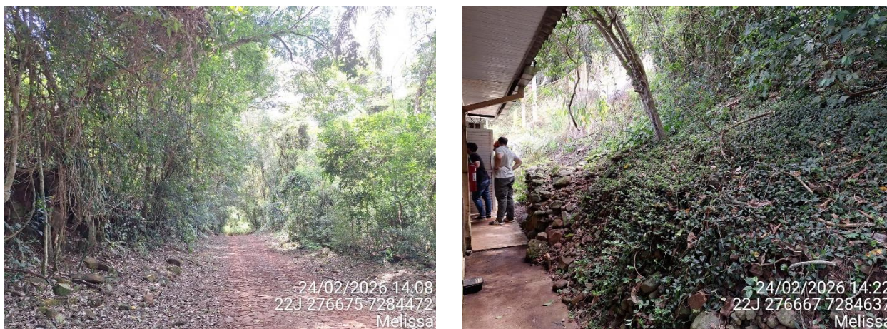
Figura 10: Remanescente florestal dando estabilidade às encostas do acesso e da parte de trás da casa de força.
