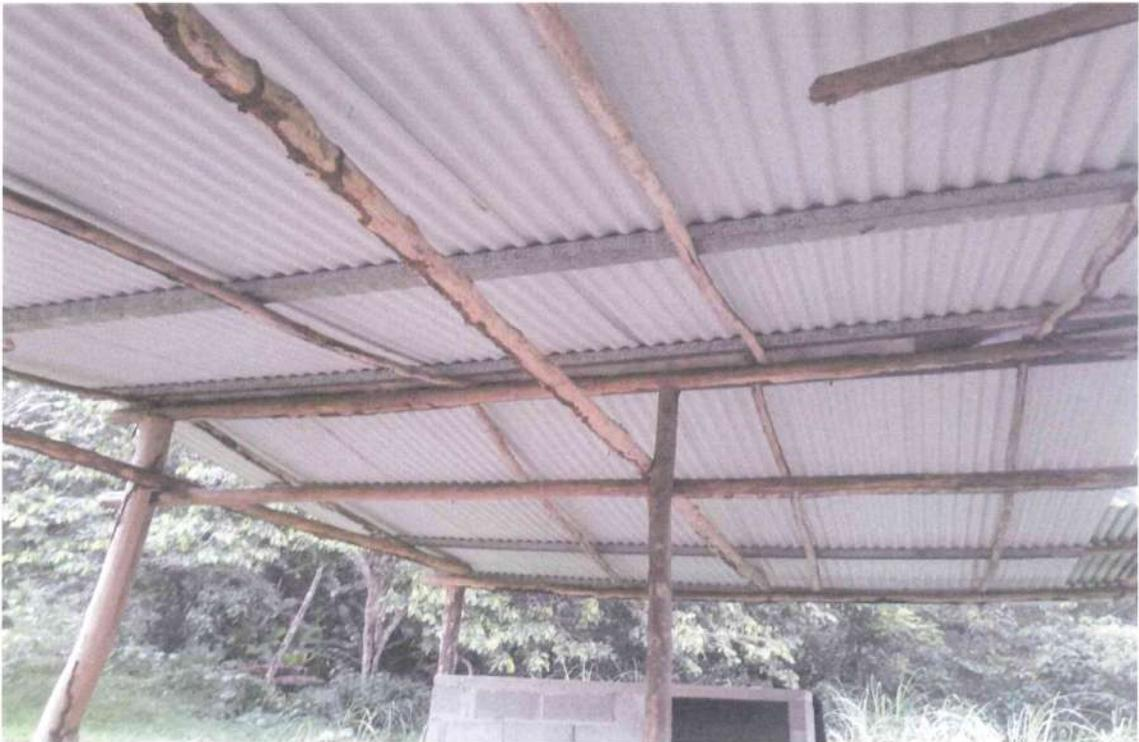
Ilustración 2. Estructura de madera existente a demoler.
