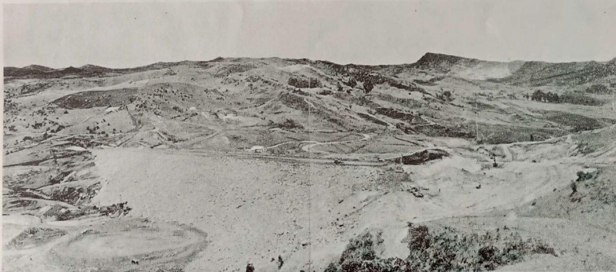
REPRESA DE CHISACA (EN CONSTRUCCION)
