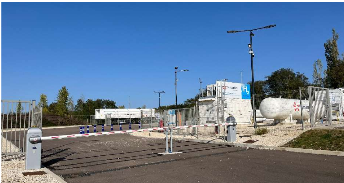
Station de recharge de bus à l'hydrogène – Auxerre (89) © Djamel Ferrand – DGSCGC
