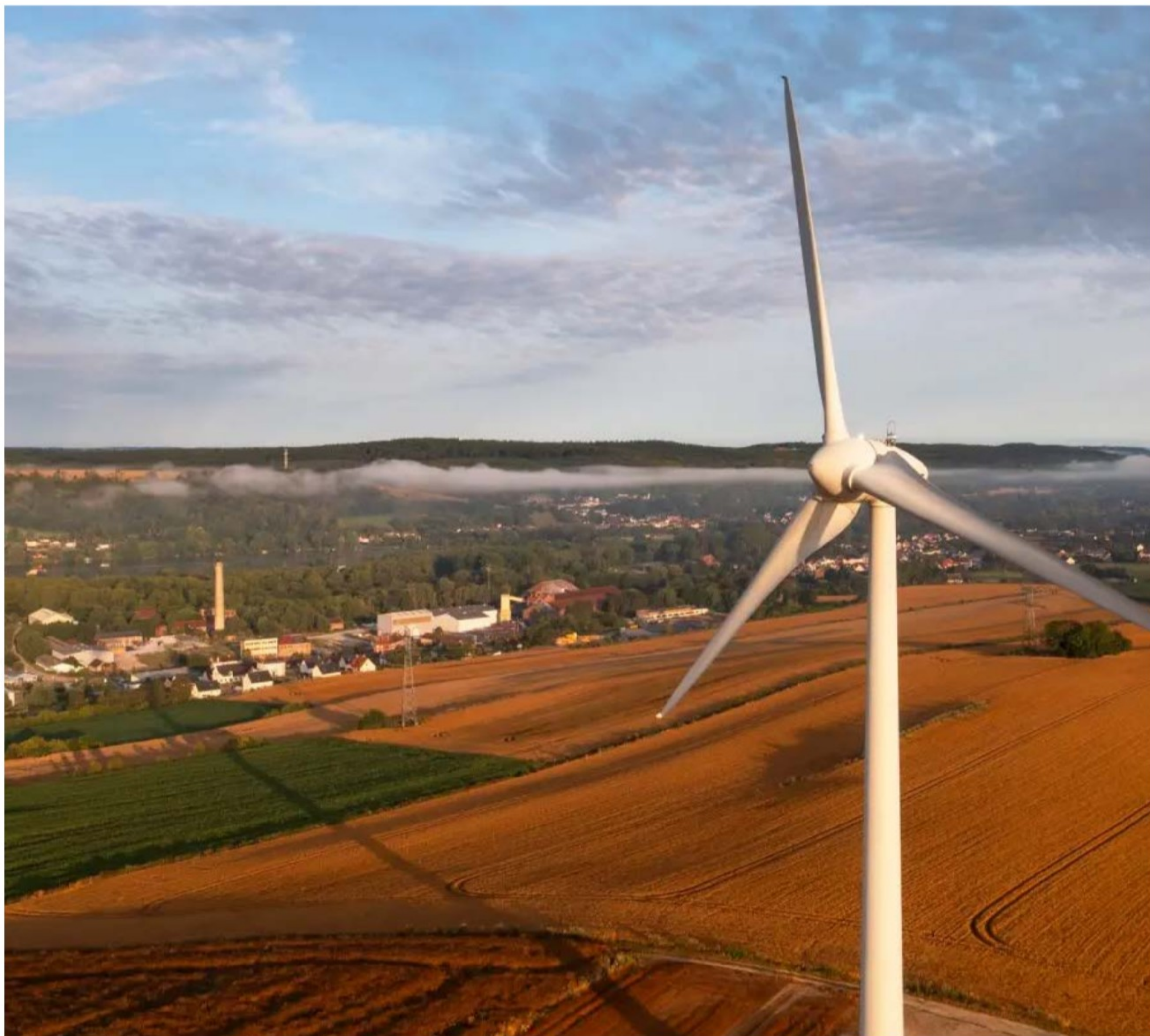
Au-delà de la décote, la structure juridique des contrats se durcit pour repousser le risque sur les vendeurs. IBERDROLA
