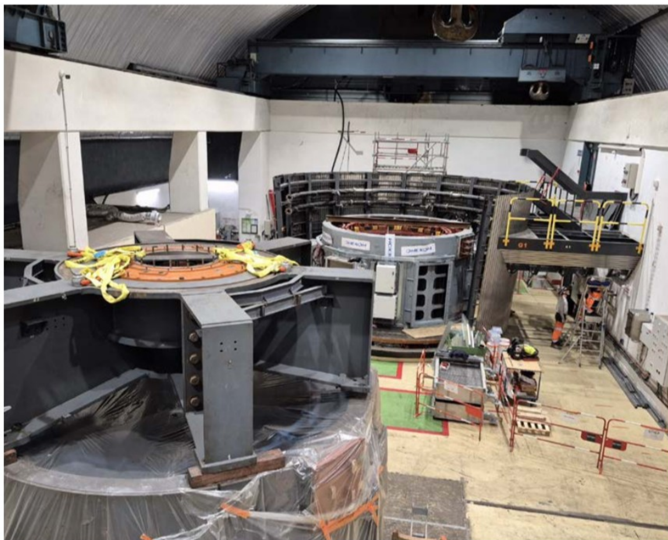
Au cœur de la centrale hydroélectrique de Montahut (Hérault), EDF Hydro a entrepris un vaste chantier d'optimisation : les deux groupes abritant les alternateurs ont été démontés et modernisés. CÉCILE CHAIGNEAU
