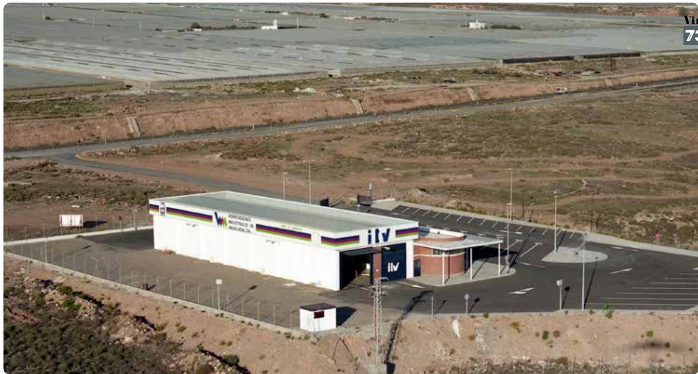
1997. Estación de ITV de Balanegra recién construida.
