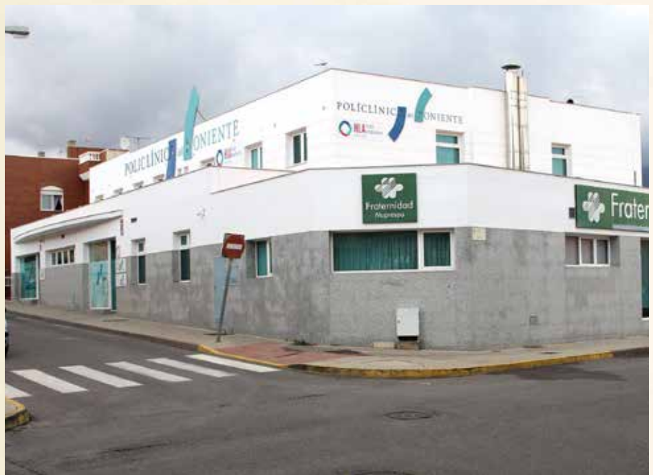
Instalaciones en Ejido Norte.
