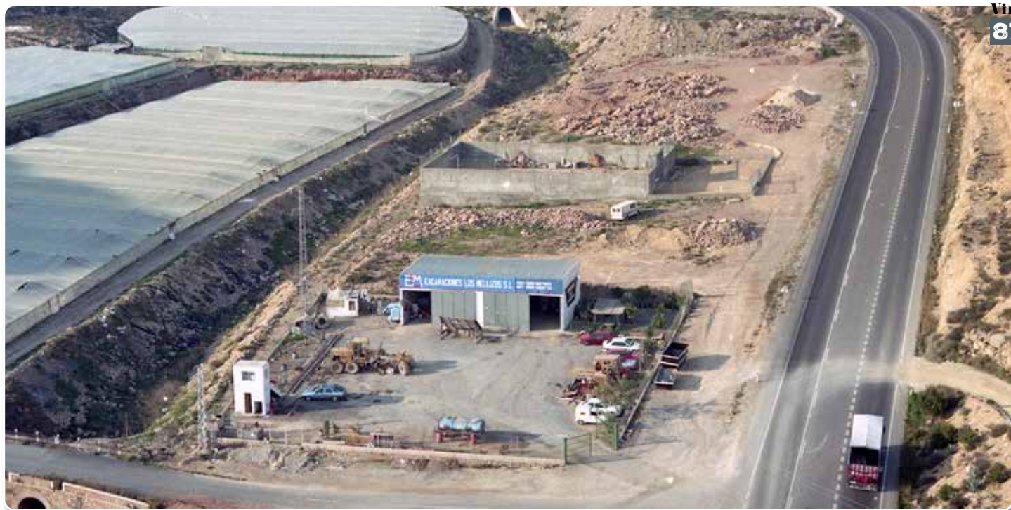
Nave de Excavaciones Los Mellizos en los Atajuelos. Año 1997.
