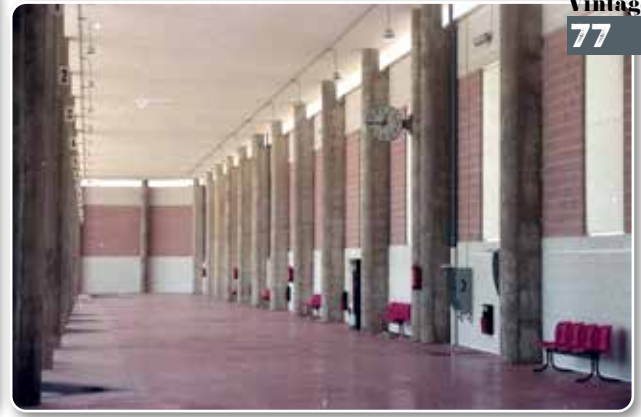
La Estación de Autobuses de El Ejido en 1996.
