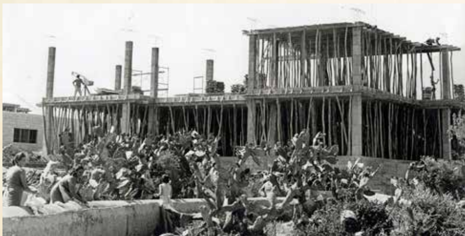
1971. El Diego Velázquez en construcción.
