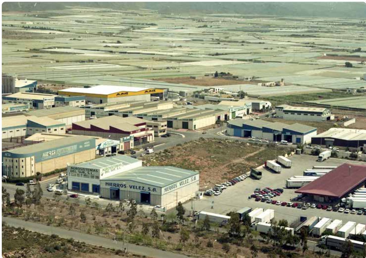
El Polígono Industrial de La Redonda en 1997. Con la antigua estación TIR en primer plano.
