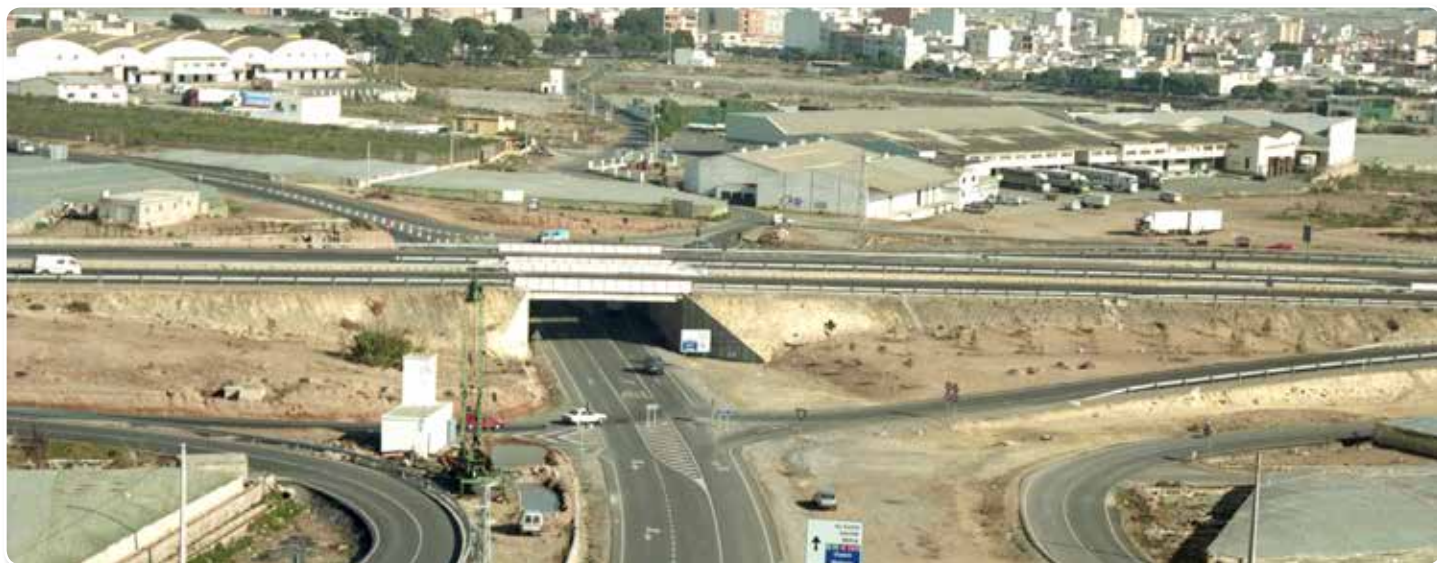
Salida de la Autovía Ejido Oeste en 1995, año de su inauguración.
