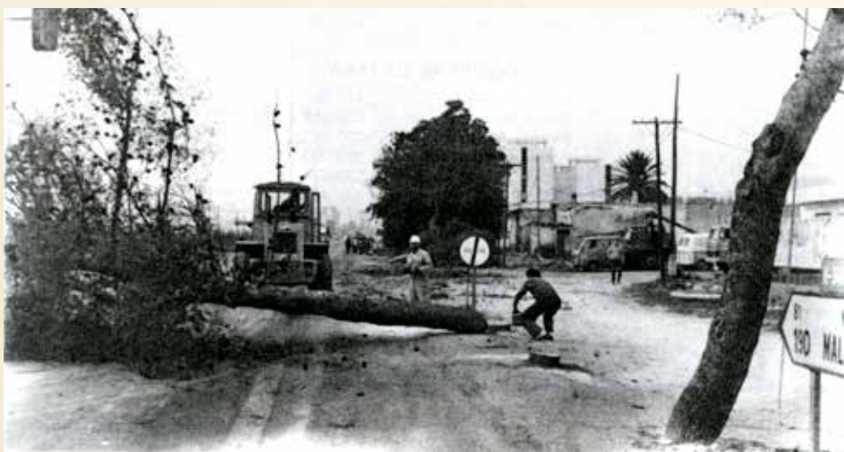
Tala de los árboles en el empalme de la Avda. Oasis. Foto Francisco González.
