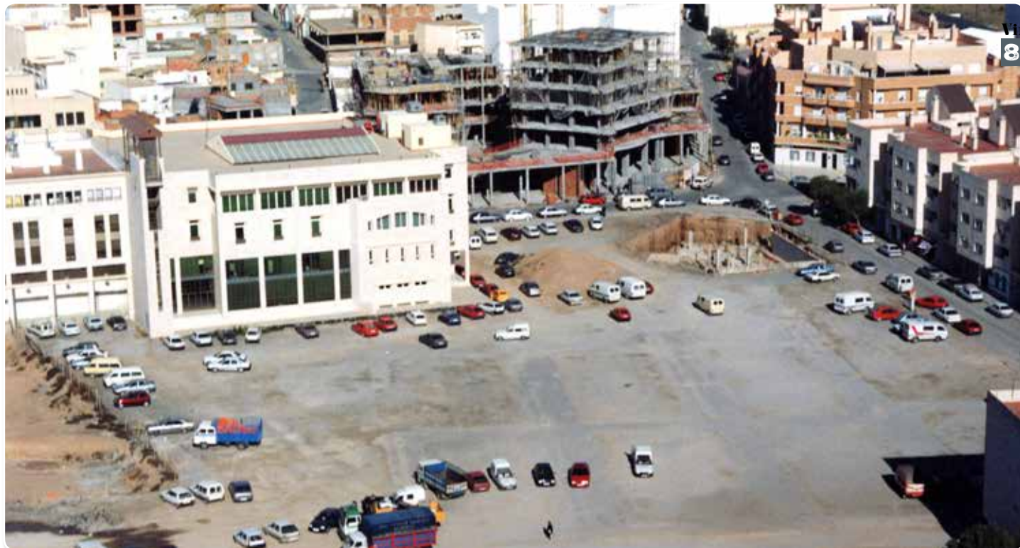
Plaza Mayor de El Ejido en construcción en el año 2000.
