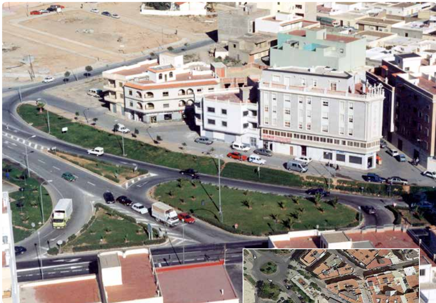
El empalme de Pampanico y Carrera de San Isidro en 1992 y vista actual tomada de Google, con la plaza del agua y la rotonda.
