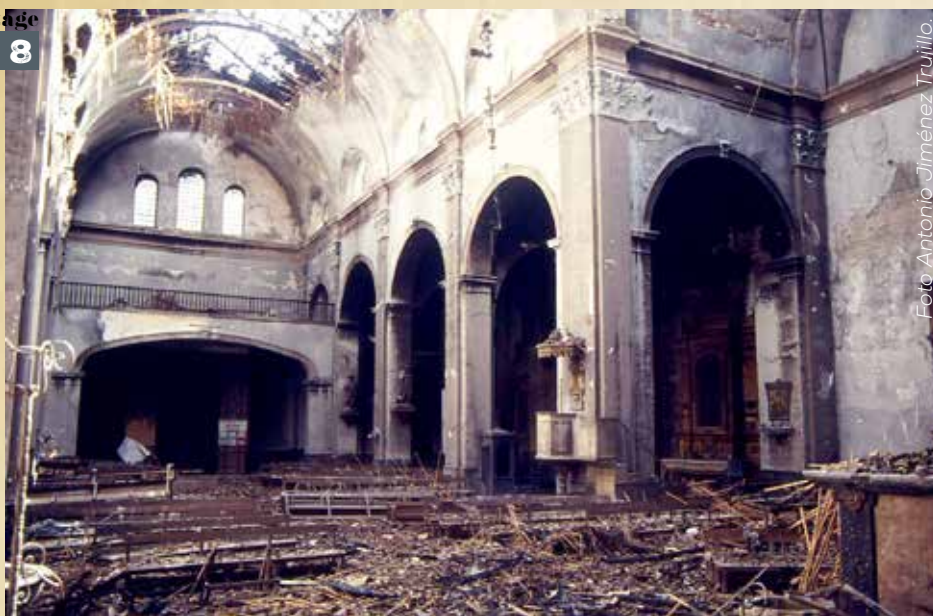
Entre los escombros se observa que los daños se redujeron al techo y al mobiliario interior.
