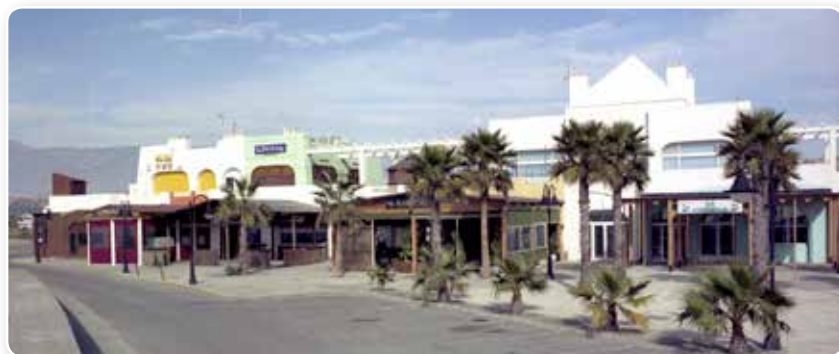
2007. Edificio Jaleo de Almerimar.
