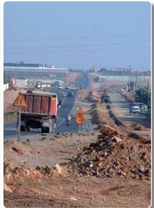
La carretera de Almerimar en obras, año 2001.
