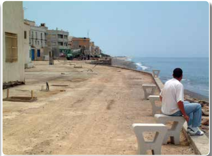
Obras en el Paseo Marítimo de Balerna.
