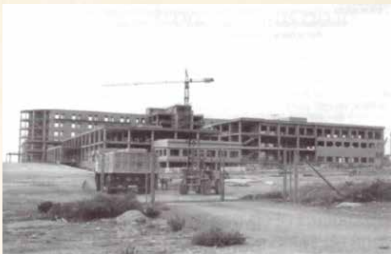
Otra vista de las obras de la primera fase en 1993.
