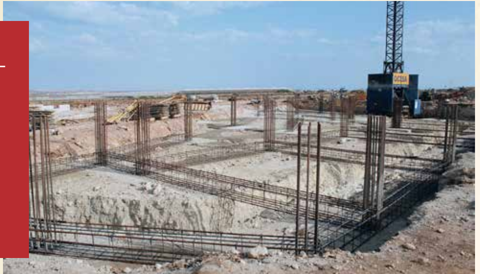
Estado de las obras en 1995. Foto Geyvan.
