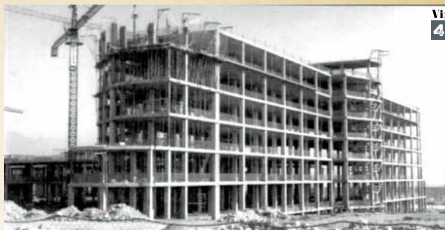
Construcción de la primera fase del Hospital en enero de 1993. Imagen de La Gaceta.
