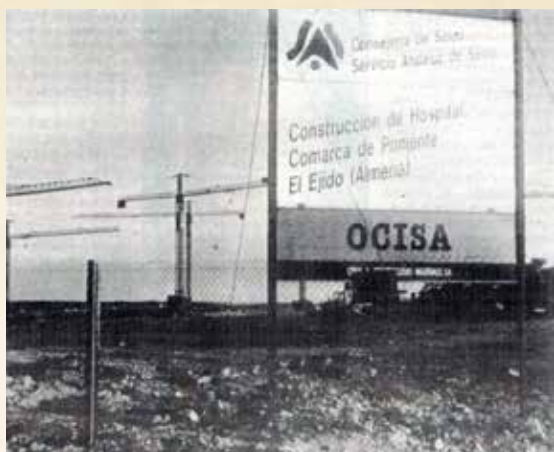
Todo preparado para el inicio de las obras en 1992. Imagen de La Gaceta.
