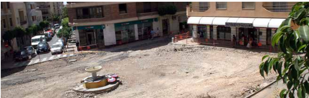
Obras de la plaza de la Iglesia en julio de 2009.
