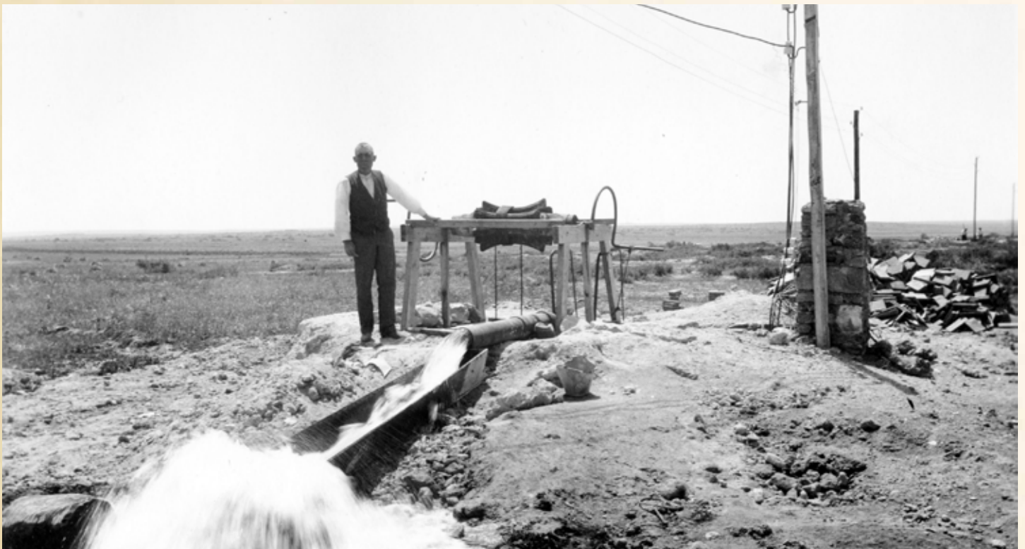
Pozo de Don García en funcionamiento, con un caudal de 90m 3 /h.
