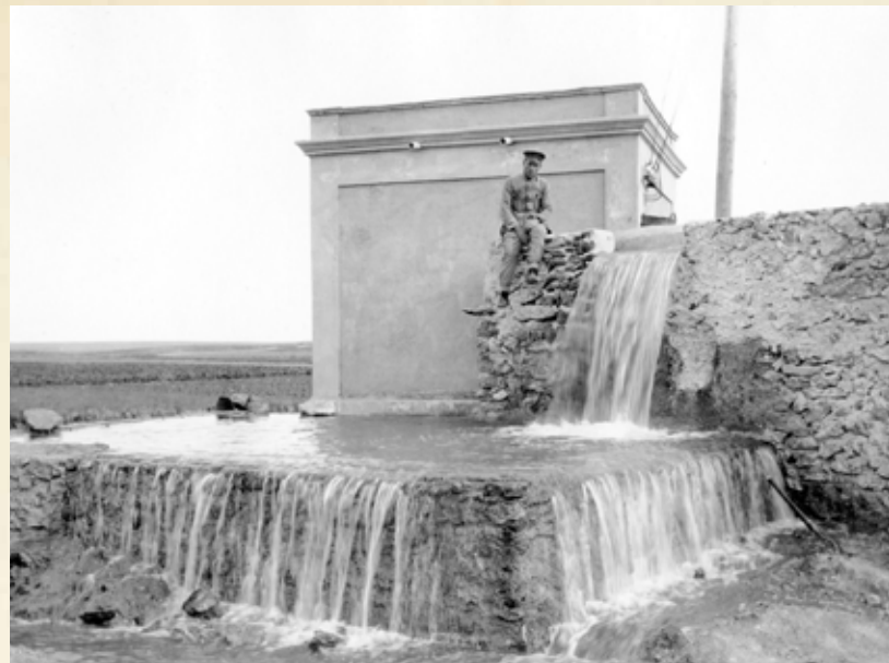
Una pose muy estudiada en el pozo Rempuja, con un caudal de 120m 3 /h desbordado.
