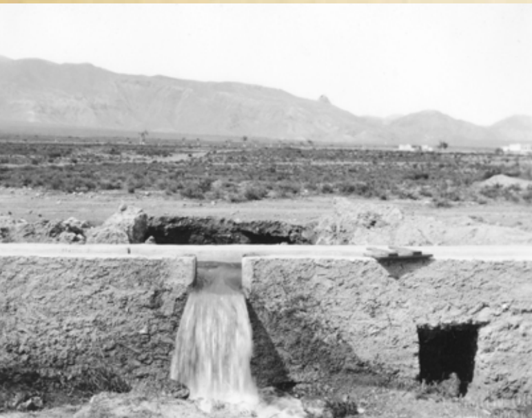
El pozo José Lucas daba salida a un caudal de 90m 3 /h.
