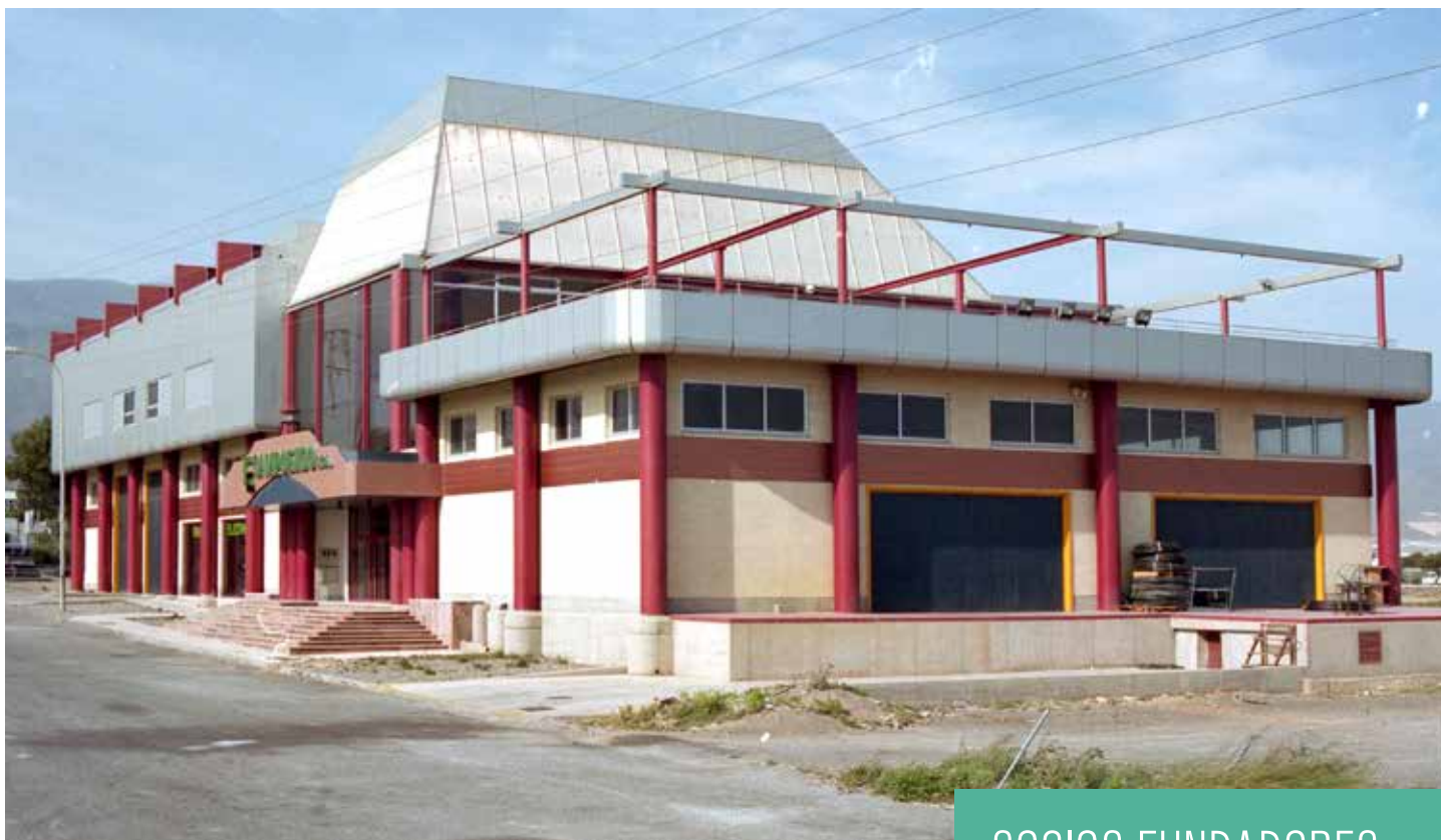
Primera sede de la Cooperativa (página anterior) en calle Toledo en el año 1981. Sobre estas líneas, fotografía del nuevo edificio recién terminado en 1998.
