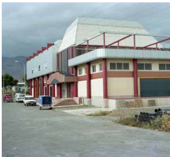
Construcción de la nave de La Costa en 1996.
