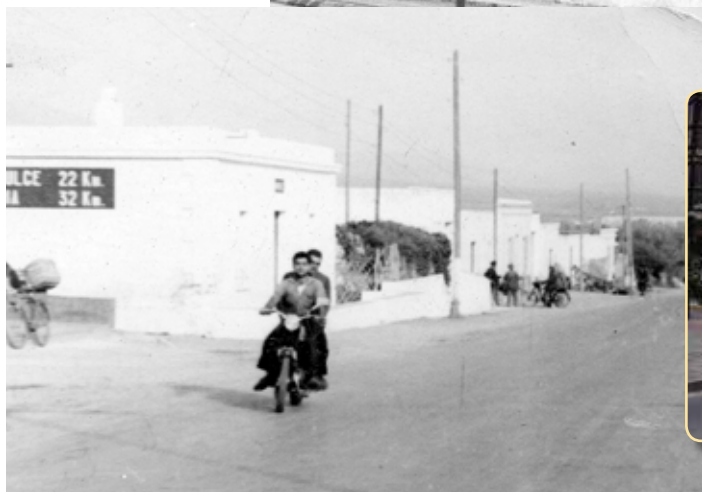
Caseta de Peones Camineros y viviendas cercanas, ahora forma parte de los edificios que rodean la plaza Mayor de El Ejido.
