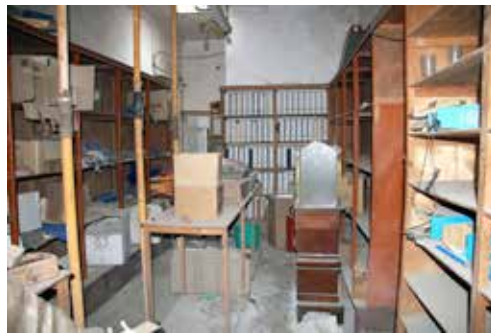
Dos imágenes del estado en que se encuentra el interior del local en la actualidad.
