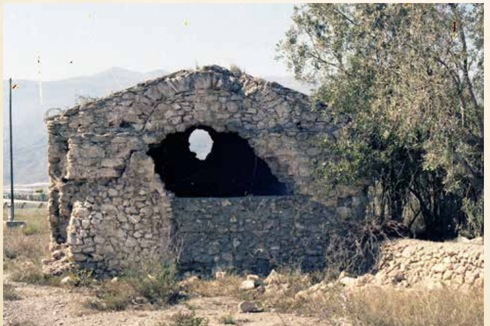
Estado en la que se encontraba la fachada sur en 1979.
