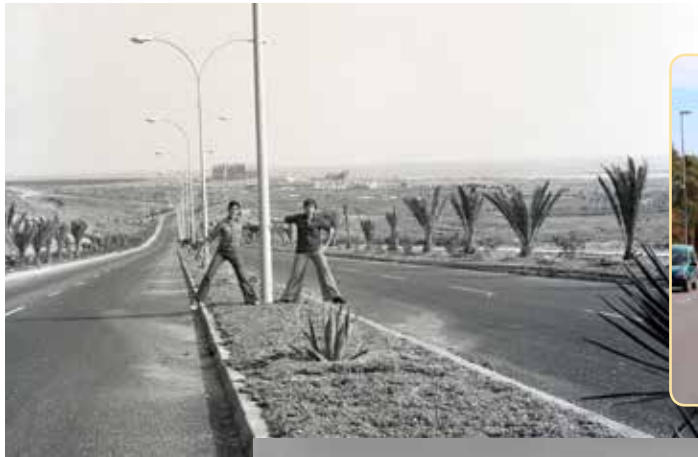
La cuesta de Almerimar en 1976. Con el puerto y las torres en construcción.
