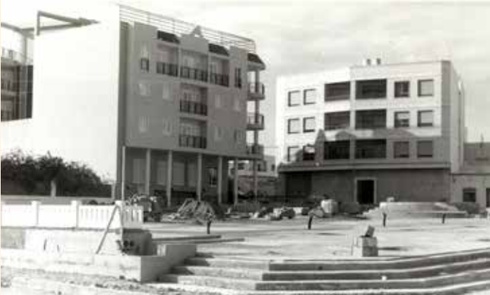
1985. Obras de remodelación de la plaza.
