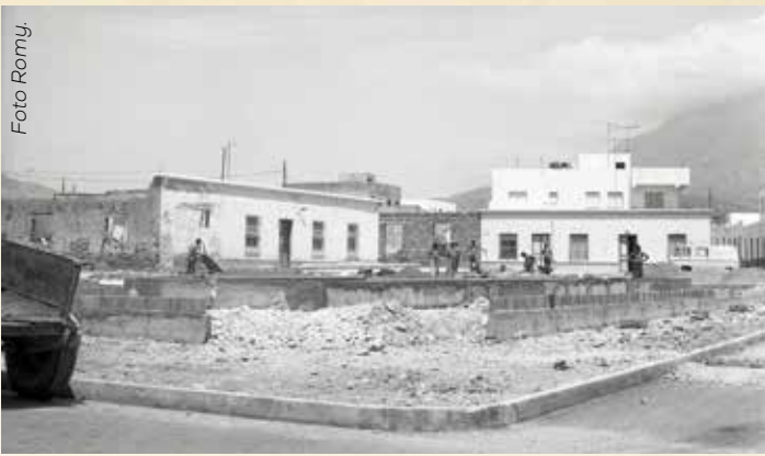
Obras de construcción de la Plaza Cervantes en 1973.
