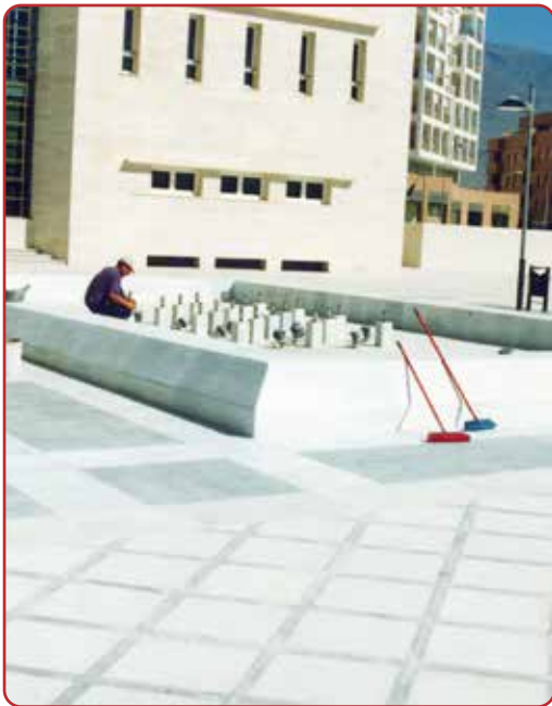
Obras en la fuente de la Plaza Mayor.
