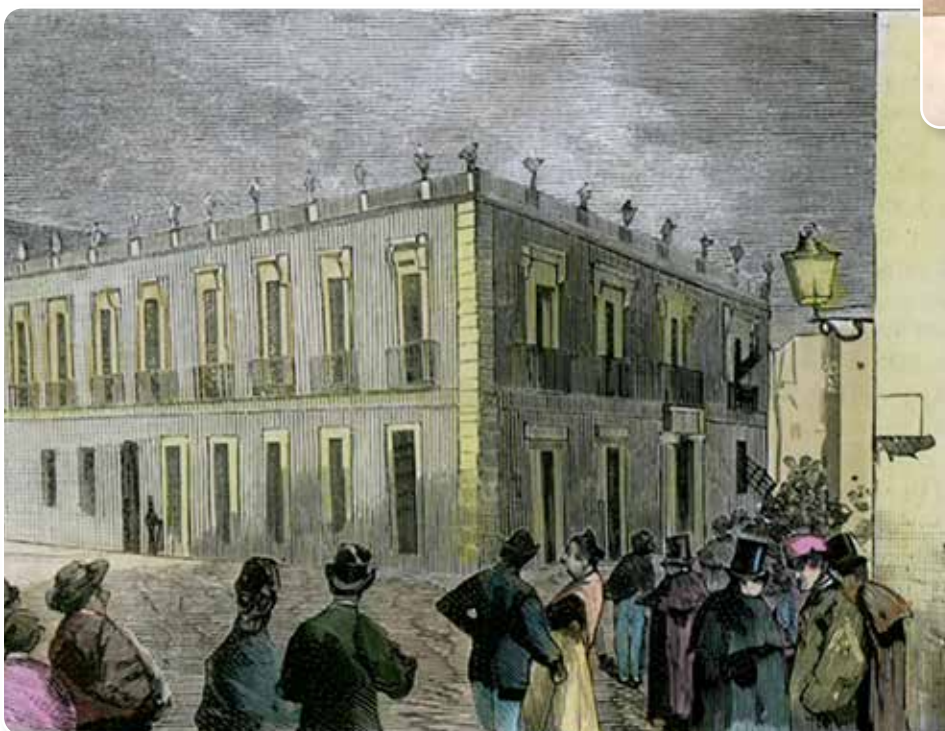
1879. Fachada de la casa de los señores de Jover antes del famoso derrumbamiento. Esta antigua casa señorial sita en la calle Arráez, esquina con la calle de la Reina, ha pasado por distintos propietarios y remodelaciones. En la actualidad, es propiedad pública y su interior alberga el valioso archivo municipal.
