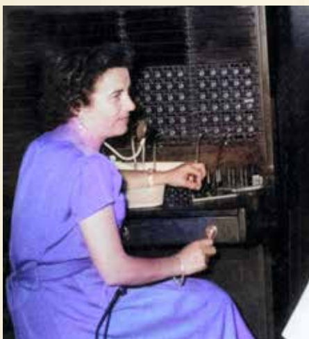
Centralita de teléfonos.
