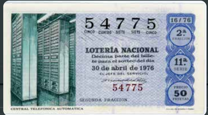
Central de Telefónica automática.
