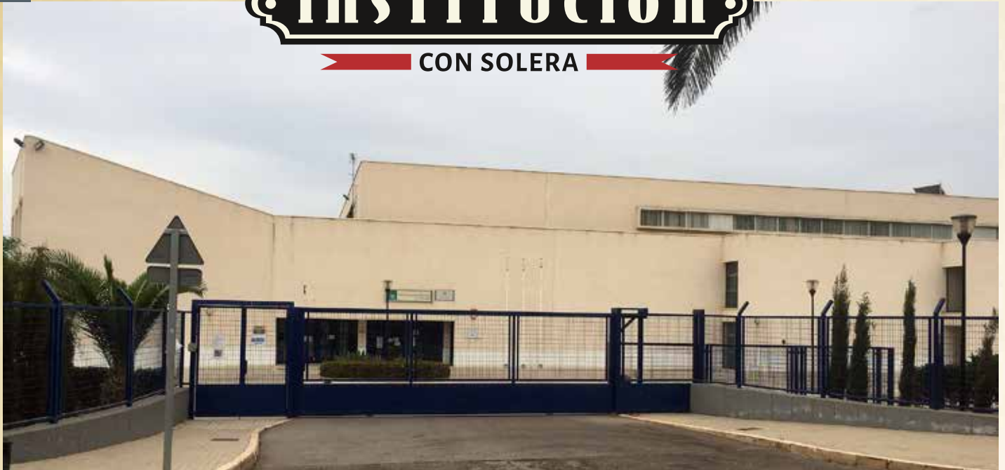
Fachada actual del instituto.
