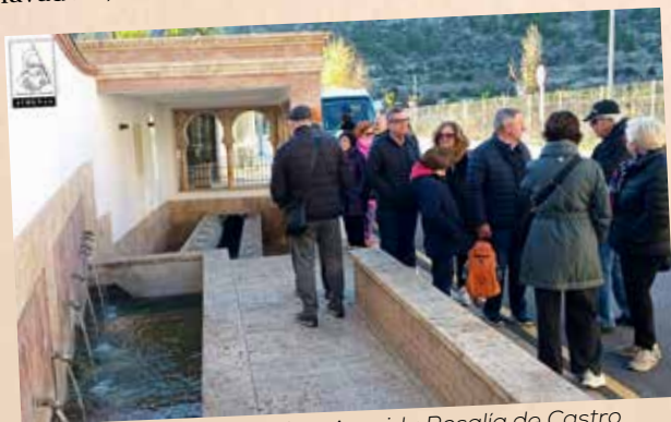
Lavadero Municipal en Avenida Rosalía de Castro.
