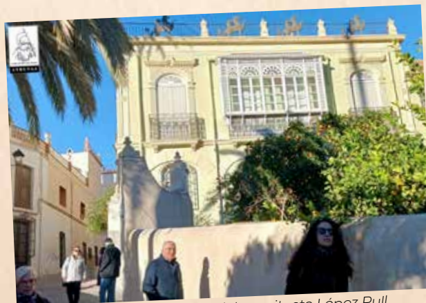
Casa de los Caballitos del arquitecto López Rull.
