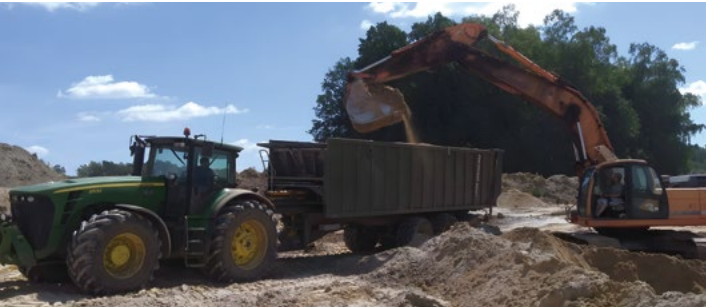
Travaux de construction
