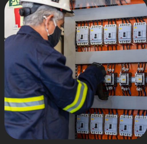
MONTAGEM DE PAINÉIS ELÉTRICOS
