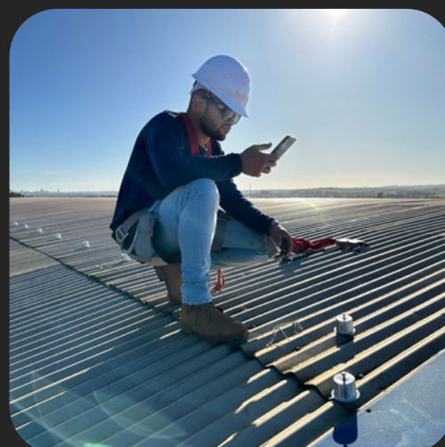
LAUDO E ADEQUAÇÃO DO SPDA
