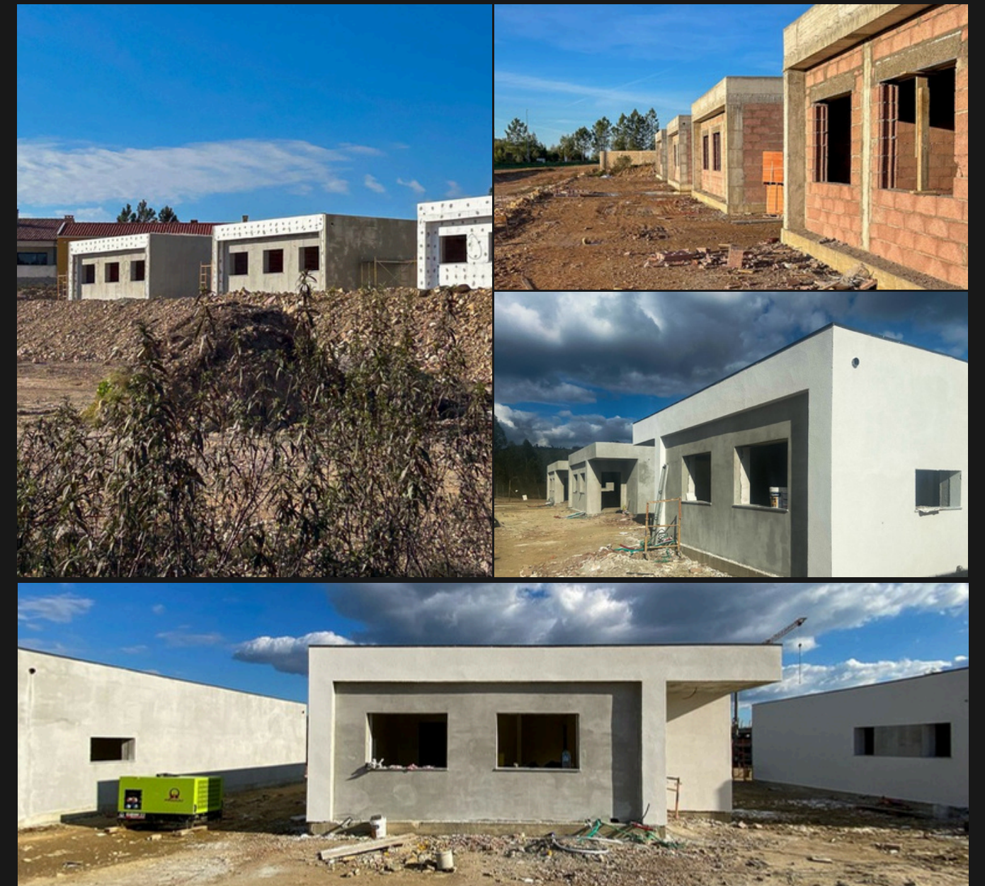
RESIDÊNCIAS VILA DE REI
