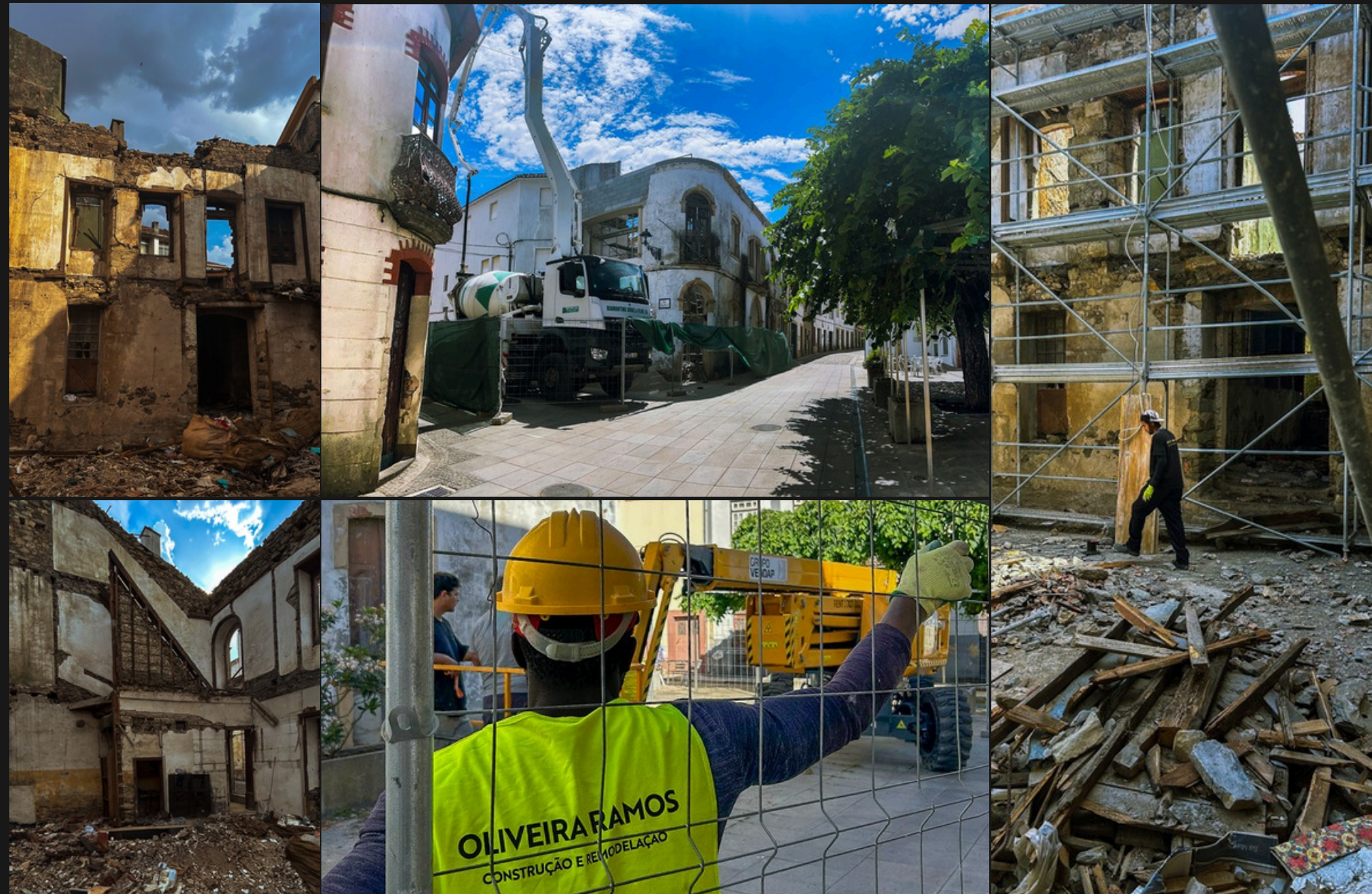
DEMOLIÇÃO PROENÇA A NOVA
