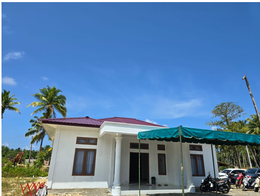
圖九：NCC: 員工宿舍及辦公室(實景)
