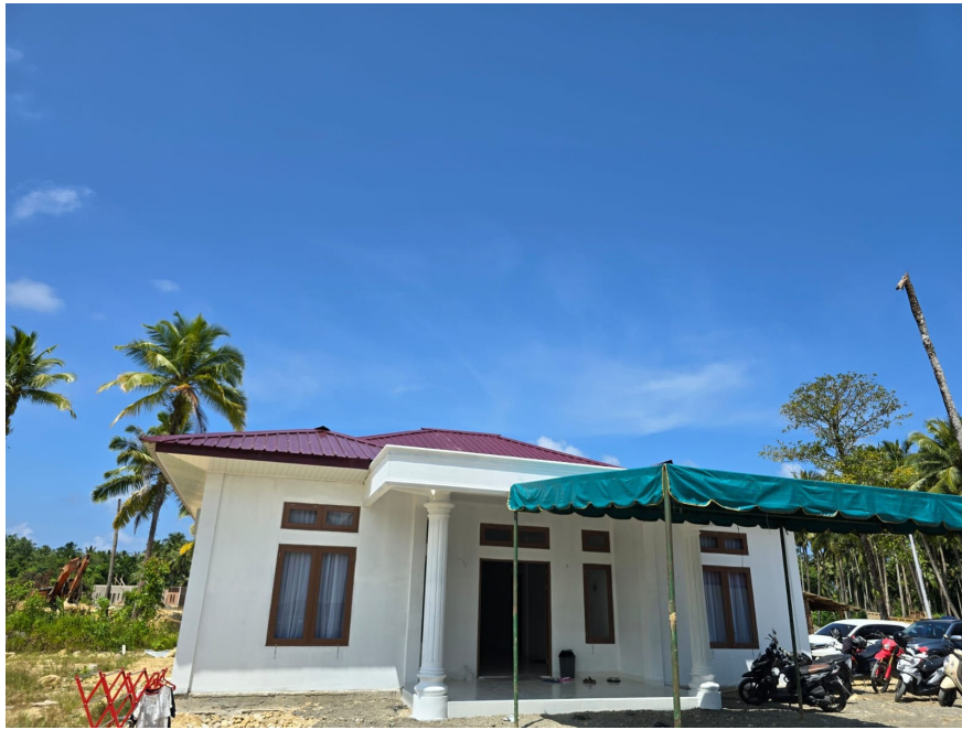
圖九：NCC: 員工宿舍及辦公室(實景)
