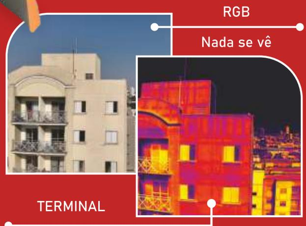
Onde podemos observar a estrutura e trincas com infiltrações, deslocamento do reboco / revestimento.
