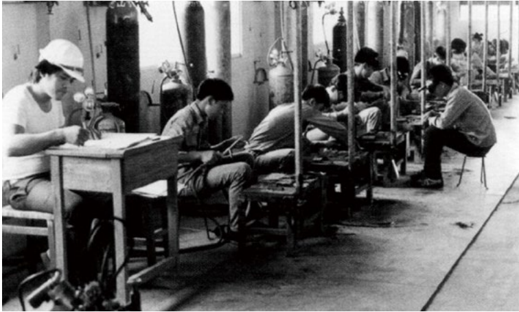
Imagen 4. Taller instalado para trabajos de soldadura en el East training Centre en 1965 (Archivos SMB) @Sociedad Misionera de Belén Image 4. Atelier aménagé pour les travaux de soudure dans l'East Training Centre en 1965 (Archives SMB) @Société missionnaire de Bethléem.
