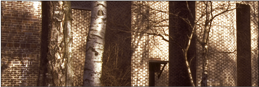
Fig. 2. Vista parcial de la fachada Sur de la Iglesia de St. Mark en el distrito de Björkhamnen, Stockholm. Fotografía del autor
