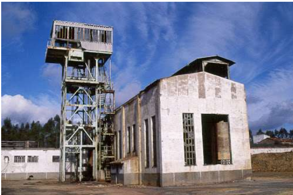
Pozo Renato – Valdelamusa (Cortegana)
