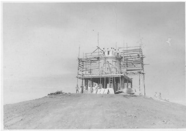
Figura 3 — Construção da Base da Estátua do Cristo Redentor (1968)
