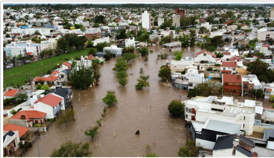
Imagen 1: Vista aérea de un barrio de Bahía Blanca inundado (evento 7-8 de marzo de 2025). Las calles se convierten en canales, evidenciando la insuficiencia del sistema de drenaje actual. 1
