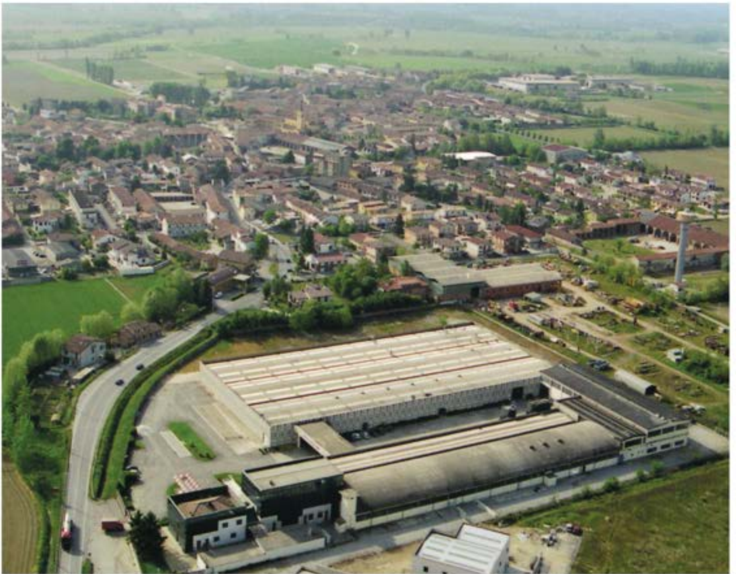
Sede della produzione e magazzino di Casalmorano, Cremona - Production headquarters and warehouse in Casalmorano, Cremona
