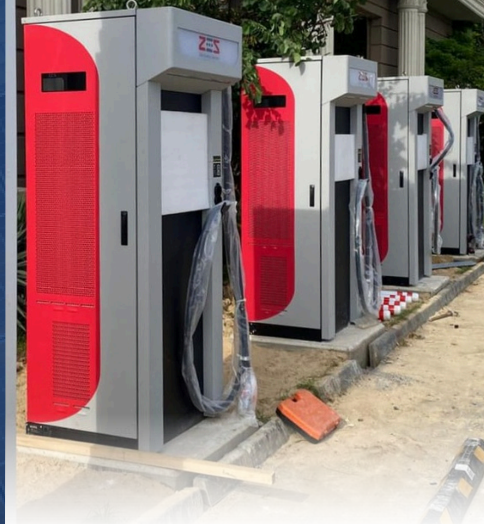
ELEKTRİK ŞARJ İSTASYON KURULUMU
