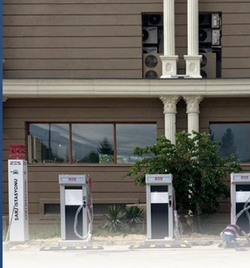
ELEKTRİK ŞARJ İSTASYON KURULUMU
