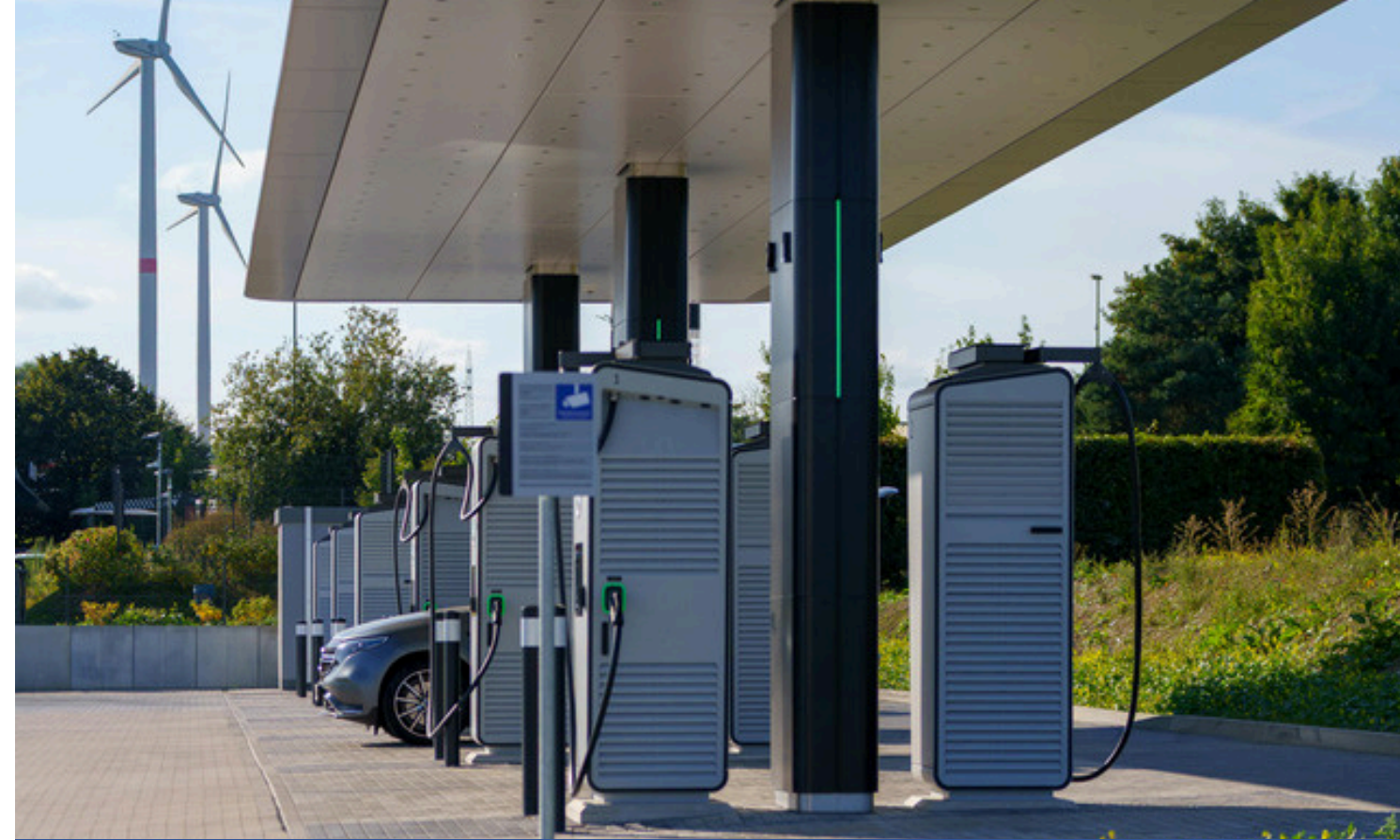
Elektrik şarj istasyon kurulumu
