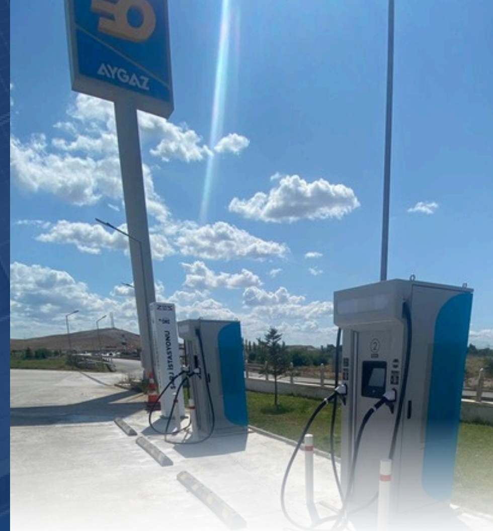
ELEKTRİK ŞARJ İSTASYON KURULUMU
